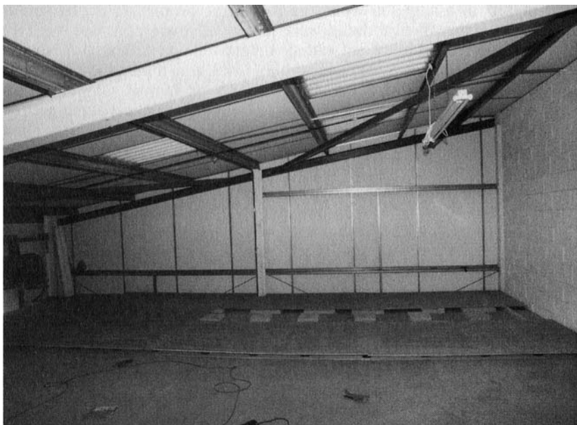
Фото 5. Частная студия в Сент Альбанз ( St Albans ), Великобритания. В качестве помещения был использован мезонин металлообрабатывающей фабрики. Под первым слоем конструкции пола типа "сэндвич" можно увидеть изолирующие блоки из высокоплотной пены.
